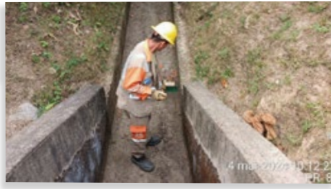
Limpieza de obras hidráulicas longitudinales y transversales
