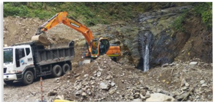
Limpieza de cauce alcantarillas
