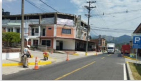
Delimitación de obstáculos laterales y vértices de bahías y bocacalles paso urbano municipio San Luis de Gaceno
