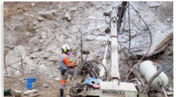
Actividad perforación para instalación de anclajes UF 1
