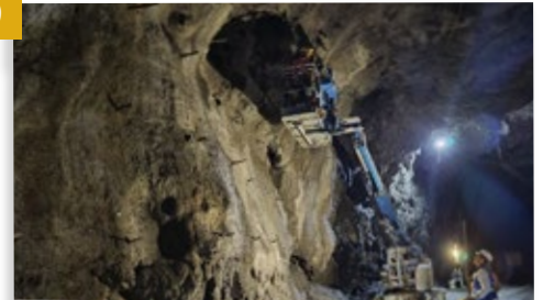
Obras de estabilización
