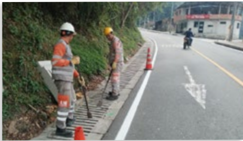
Limpieza de obras hidráulicas longitudinales y transversales
