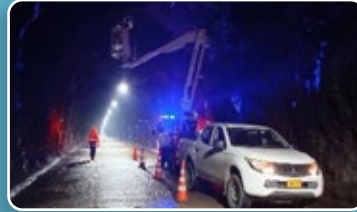
Acompañamiento en actividad de trabajo en alturas - Túnel El Polvorín.
